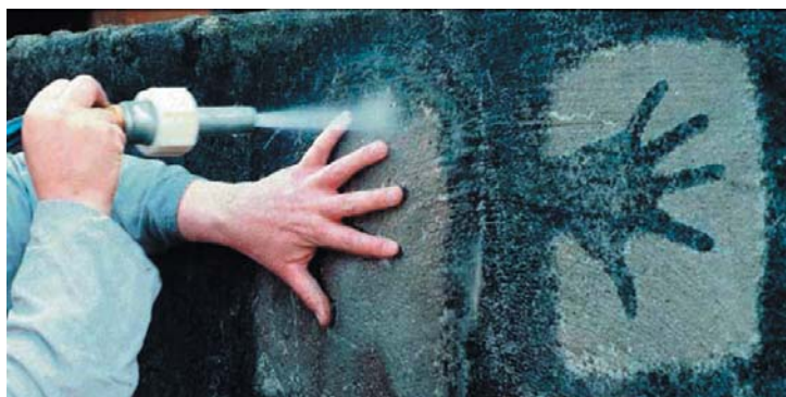
Figura 15. Pruebas de limpieza en exteriores de edificios históricos con chorro de arena de presión controlada.
